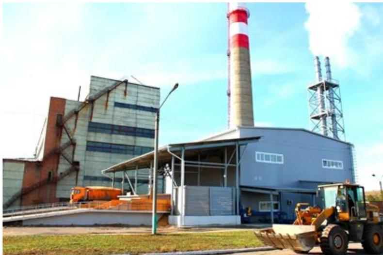
*В Свирске реализован проект по техническому перевооружению центральной котельной, конечным результатом внедрения стала установка трех котлов, работающих на древесных отходах. Проект позволил увеличить выработку тепловой энергии на 10 176 Гкал/год и обеспечил потребителей МО «город Свирск» услугой бесперебойной, круглогодичной подачи горячего водоснабжения.*
